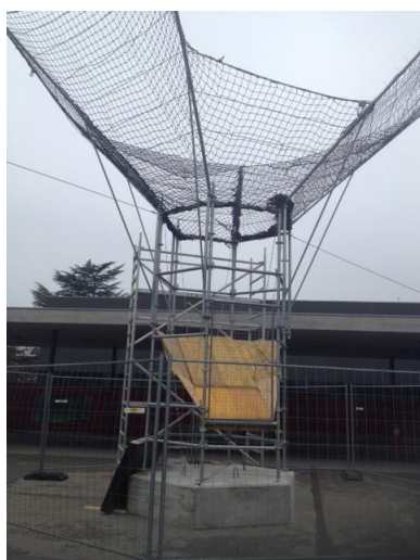
Montage de la structure
