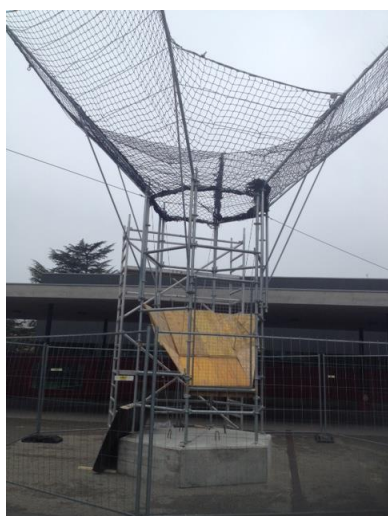
Montage de la structure
