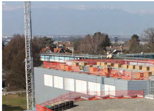
Installation de 1000 m 2 de panneaux photovoltaïques, mars 2011
