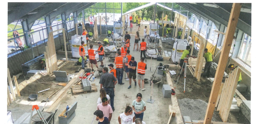
Les chantiers des jardins en début de réalisation, sous l'œil des examinateurs (vestes rouges) et du public, lors de l'édition du concours 2022, à Fribourg. Photo: AX Wurst
