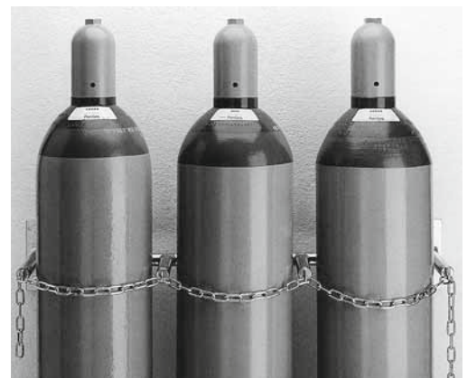
Fig. 3: fixation de sécurité pour bouteilles de gaz.
